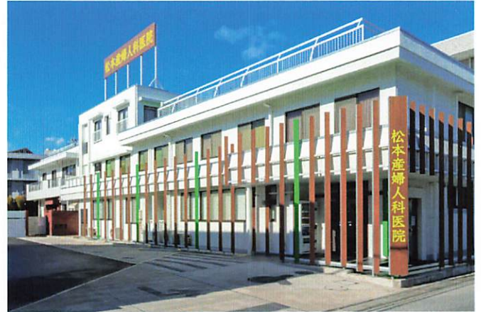
写真1 現在の当院外観
